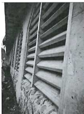
Imagen 2. Esquema del cerramiento de cada apertura mediante una estructura de madera tipo persianas (esquina superior derecha) y modelos de persianas ya realizadas en otras galerías.
