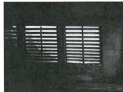
Imagen 2. Esquema del cerramiento de cada apertura mediante una estructura de madera tipo persianas (esquina superior derecha) y modelos de persianas ya realizadas en otras galerías.
