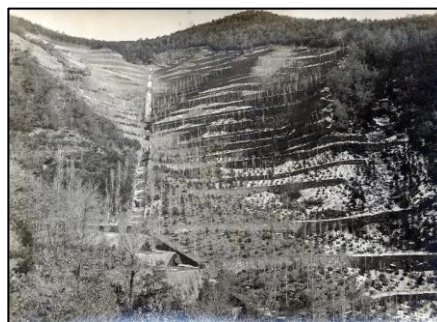
Exemple équivalent de terrasses, complété par la revégétalisassions d'arbres et arbustes pour améliorer l'ancrage et le drainage en Arratiecho en Biescas
