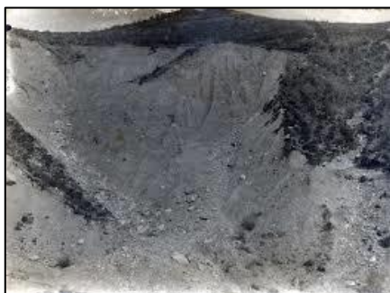
Exemple équivalent de terrasses, complété par la revégétalisassions d'arbres et arbustes pour améliorer l'ancrage et le drainage en Arratiecho en Biescas
